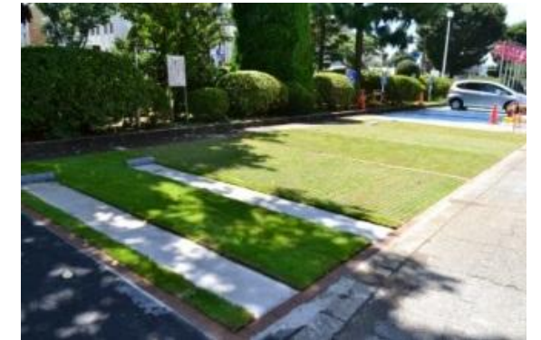
県庁敷地内緑化モデル駐車場
