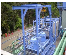
トンネル工事濁水
